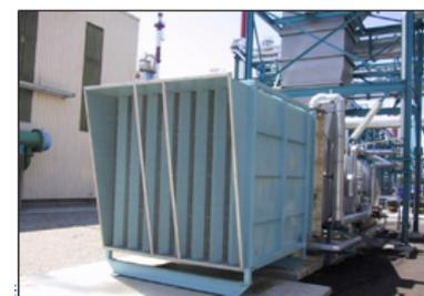
Figure 7 : silencieux aspiration sur ventilateur centrifuge.
