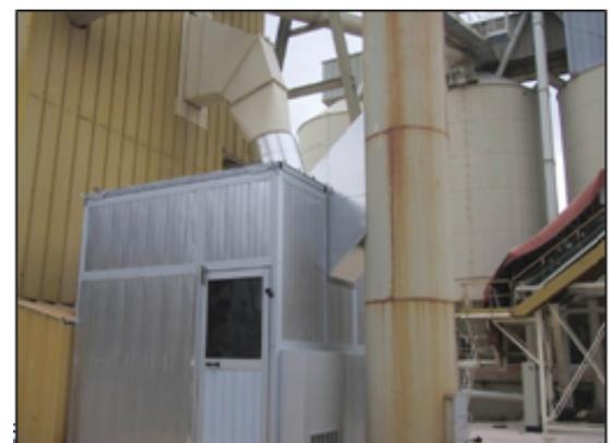
Figure 11 : capotage sur ventilateur centrifuge.
