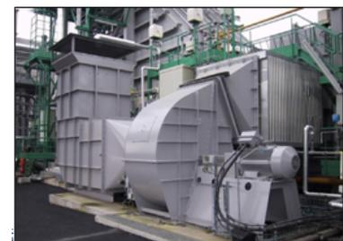
Figure 6 : silencieux aspiration et refoulement sur ventilateur centrifuge.
