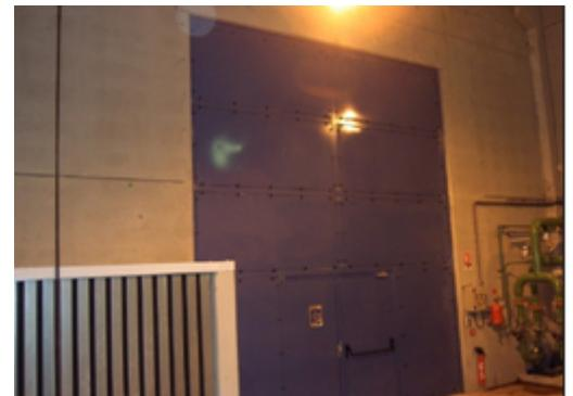
Figure 10 : porte pour local GTA avec deux vantaux.
