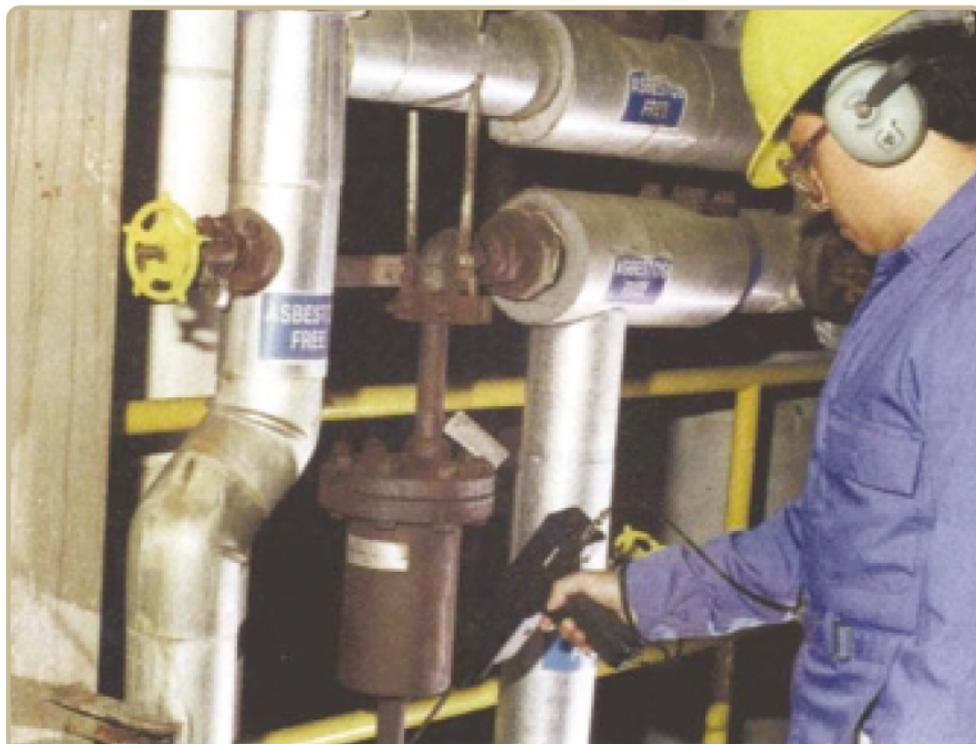
*Figure 3 : dans les mains d'un technicien expérimenté, ces appareils apportent une analyse fine du fonctionnement des purgeurs.*
