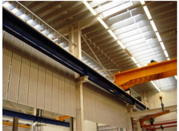
Intégration du réseau de baffles suspendus au dessus du pont roulant et de l'éclairage existant
