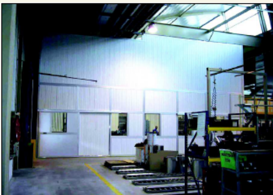
Traitement par mise en œuvre de panneaux PCC 300 A.
