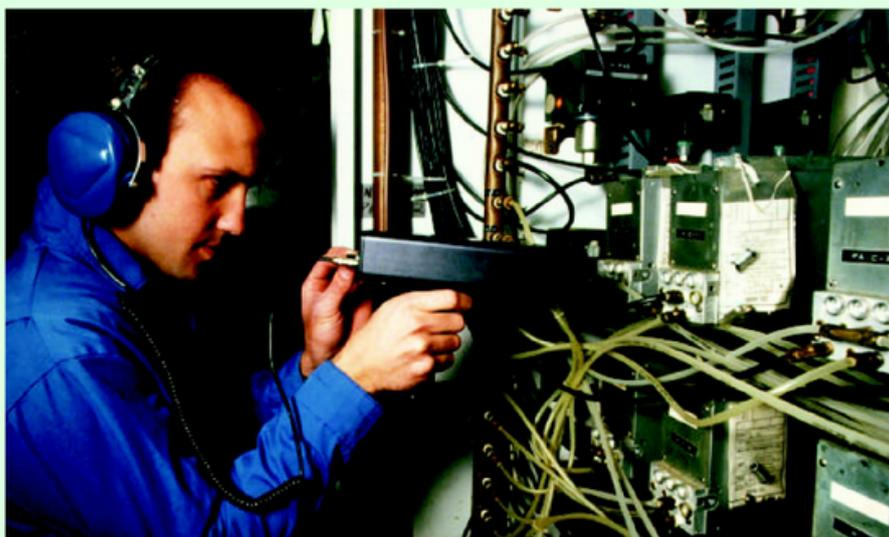
**L'air comprimé est l'une des énergies les plus chères à produire. Avec un Ultraprobe™, l'opérateur peut détecter rapidement les fuites sur des installations en service. Le responsable maintenance pourra planifier les réparations durant les arrêts. L'avantage des ultrasons réside dans la détection par l'opérateur des fuites dans un environnement audible très bruyant.**
