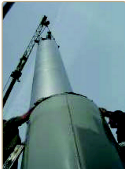
Figure 8 : silencieux résonateur.
