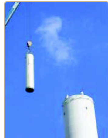
Figure 10 : silencieux absorbant + résonateur incinération de déchets.
