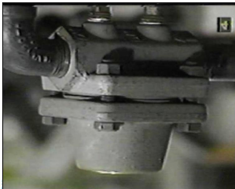
Le principe de fonctionnement de ces purgeurs repose sur la différence de température entre le condensat et la vapeur. Également connus sous les noms de "Purgeurs à régulation de température" ou "Purgeurs à pression équilibrée".
